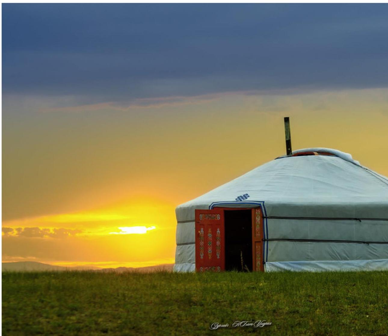
蒙古包形状圆形，利于全面占用住宿面积，低矮便于游动，最适合于常年刮风中保持稳定。使用毛毡围栏修饰能遮挡寒冷保持温暖，蒙古包圆形顶窗起到通风，照明作用。
